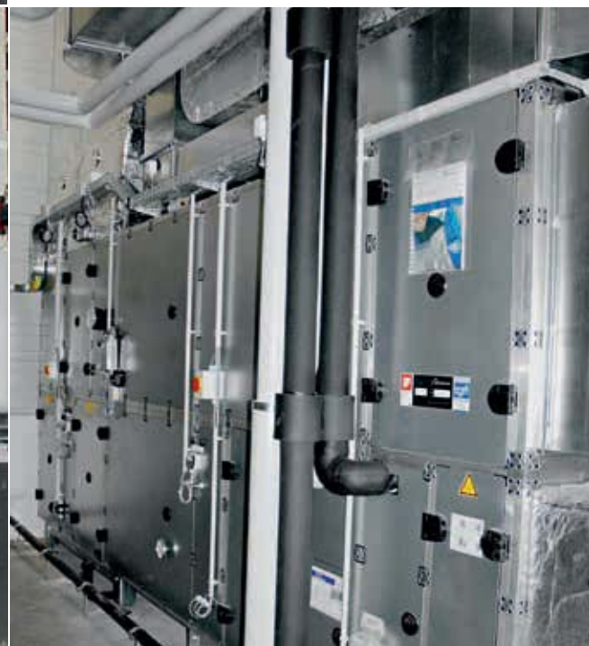
Die Lüftungsanlagen für die Nebenräume wurden gemeinsam positioniert.
